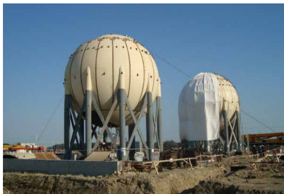
İzobutan üçün sferik çənlər. Boru stellajlarının quraşdırılması başlamışdır və davam edir
