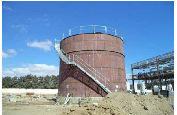
Mineralsızlaşdırılmış su çəni. Çənin quraşdırılması başla çatmışdır
