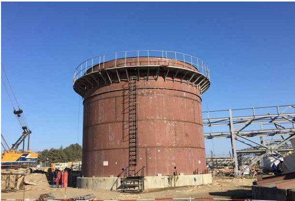
Mineralsızlaşdırılmış su çəni. Çənin quraşdırılması başla çatmışdır
