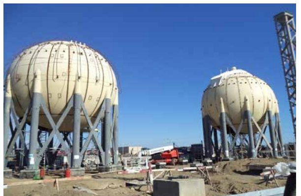
İzobutan üçün sferik çənlər. Boru stellajlarının quraşdırılması başlamışdır və davam edir
