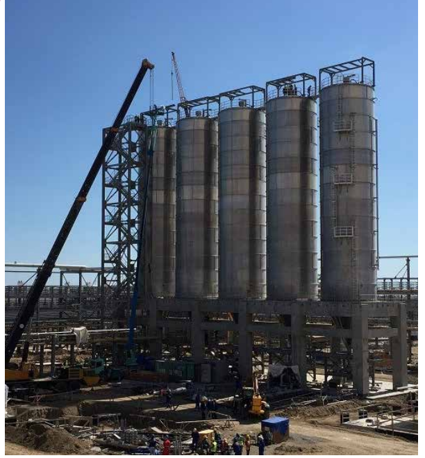
Homogenləşdirmə/ Qarışdırıcı silos. Çənlərin quraşdırılması başla çatmışdır
