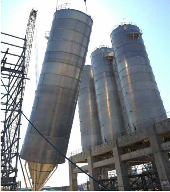
Homogenləşdirmə/ Qarışdırıcı silos. Çənlərin quraşdırılması başla çatmışdır
